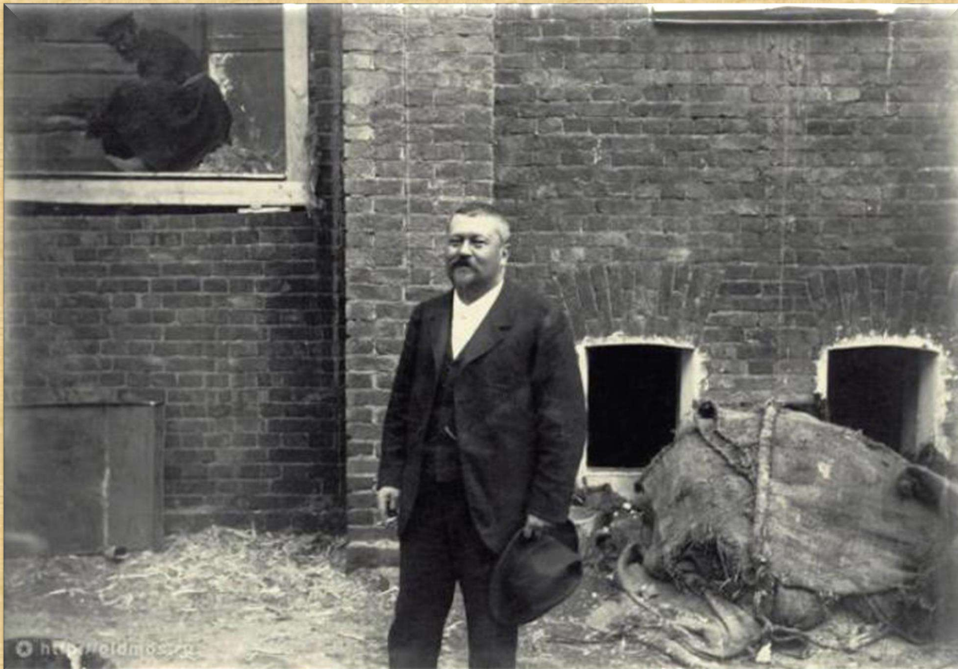
Савва Морозов на строительстве здания МХТ
